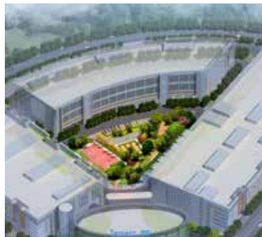
腾讯天津数据中心
