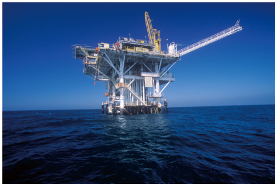
油气生产设施地理分散、跨度大
