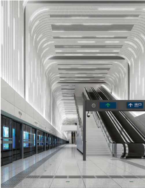
武汉地铁7号线, 8号线和11号线 地铁站厅 方案: 静态平衡阀+PICV 产品: 约400套VPIC, 100套VAFB和若干静态平衡阀
