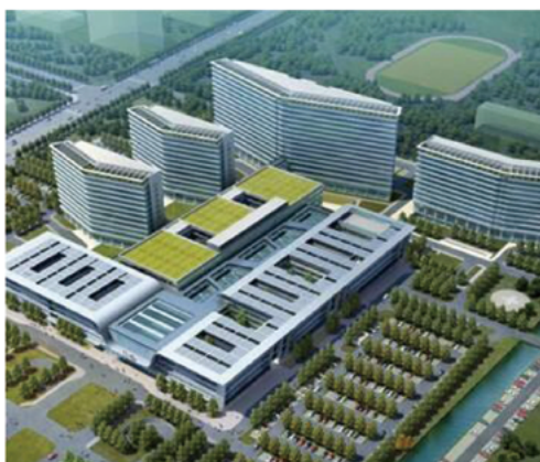
苏州吴江第九人民医院 门诊和病房大楼
