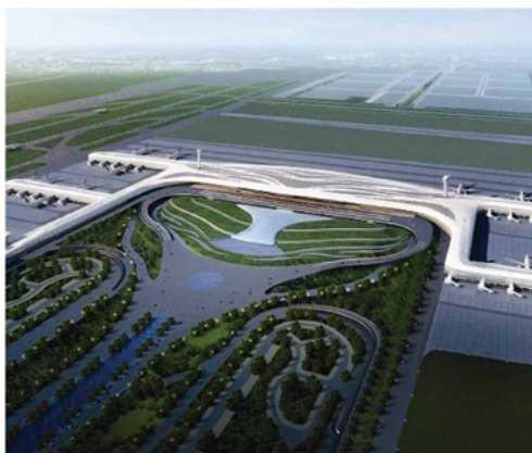
武汉天河机场T3航站楼 航站楼
