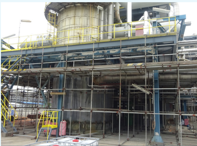
图10:上海某石化厂使用霍尼韦尔 氟碳树脂涂料的设备
