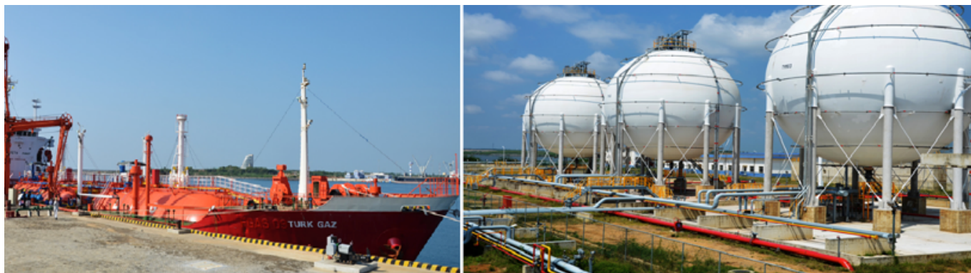
斯里兰卡 H 罐区 LPG 液化气码头卸船及罐区全貌
