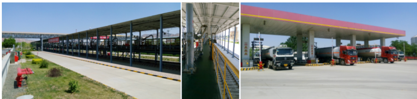
西固油库火车栈桥和汽车装车栈桥
