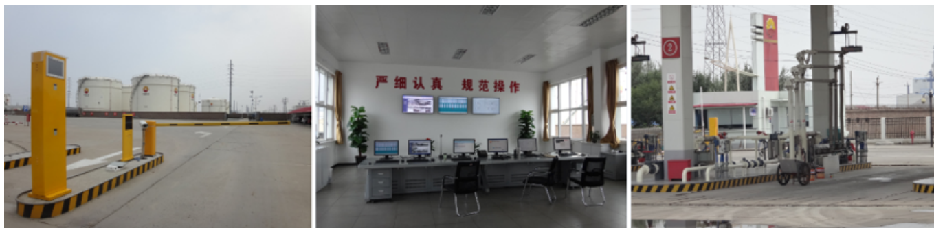
中国石油大港油库入口大门、中控室和发油岛
