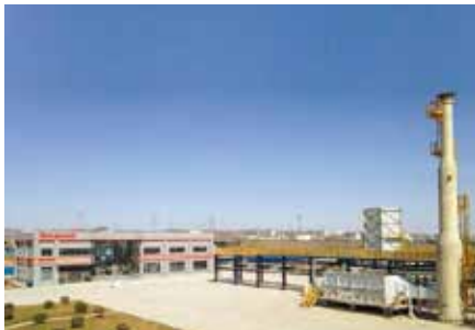
霍尼韦尔UOP凯勒特的燃烧测试中心 - 中国
